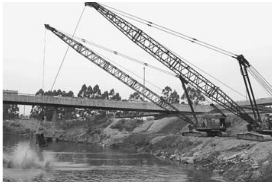
Draglines são utilizadas para retirar material e permitir o alargamento do rio, que deverá chegar a 45 metros
