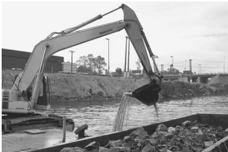
Entre Osasco e Santana de Parnaíba foram retirados 4 milhões de metros cúbicos de rochas e terra do leito do rio
